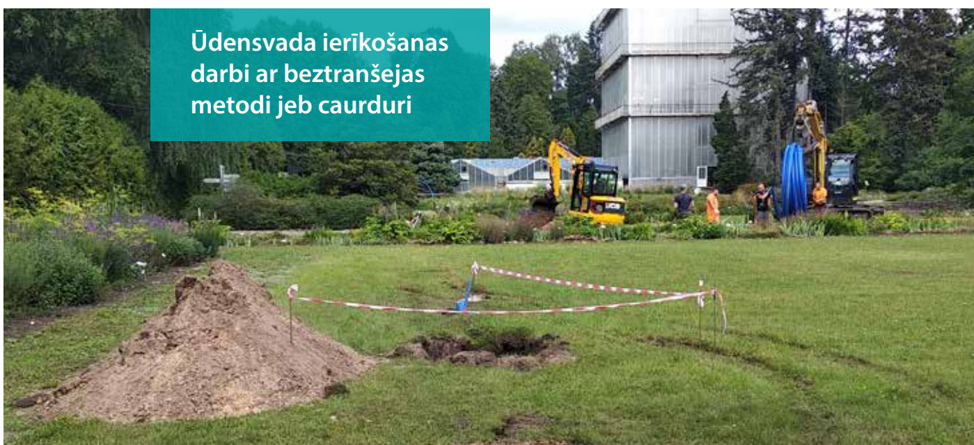
Laterālā ūdensvada ierīkošana sprinkleriem
