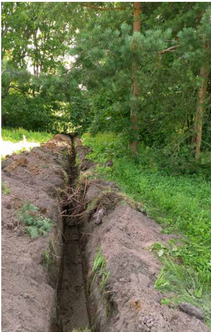
Ūdensvada ierīkošanas darbi ar atvērtās tranšejas metodi
