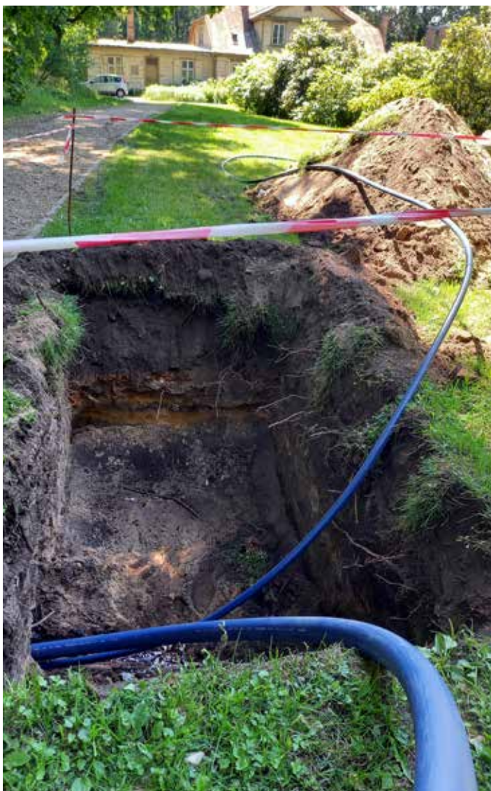
Ūdensvada ierīkošanas darbi ar beztranšējas metodi jeb caurduri
